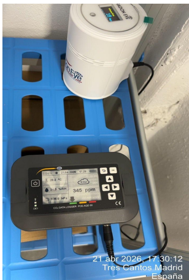
Ilustración 28: Instalación de medidor de radón y registrador de datos de calidad del aire. Fuente: propia.
