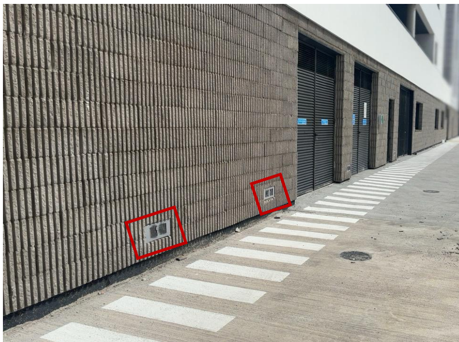
Ilustración 25: Abertura de ventilación al exterior. Fuente: propia.
